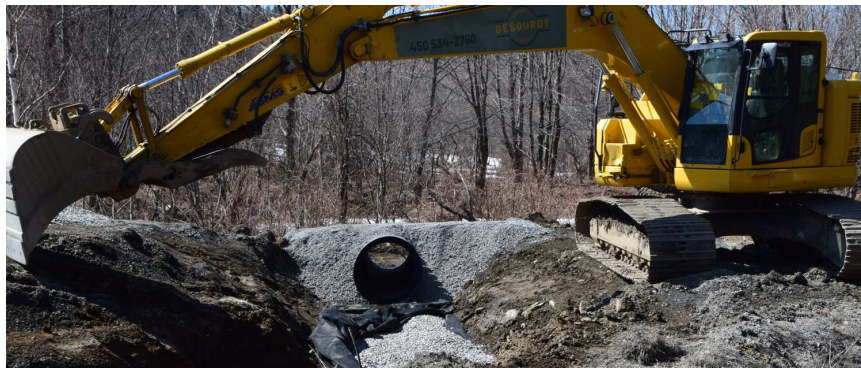
Ponceau de la Tour
